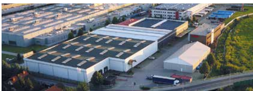
Sediul central și centru de logistică – Skawina, Polonia
